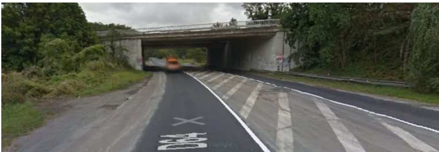
VISUEL N°2 : Passage sous la RN 184
